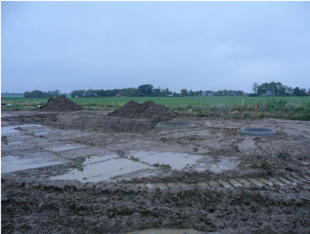
Foto 1: Bau des Drängrabens 1. 11.10.2017 (Juliana Tatzelt)
