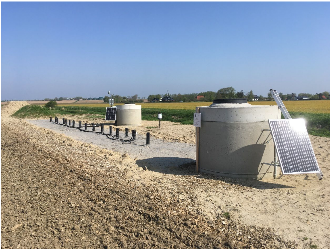
Foto 6: Blick auf den Drängraben. 30.4.2018 (Juliana Tatzelt)
