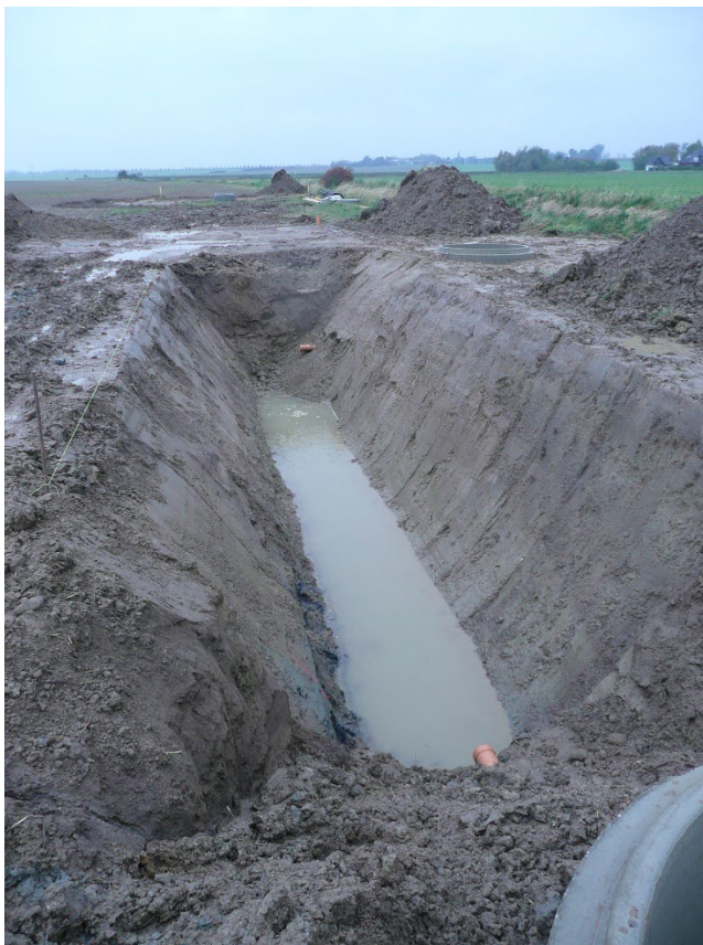
Foto 2: Bau des Drängrabens 2. 11.10.2017 (Juliana Tatzelt)
