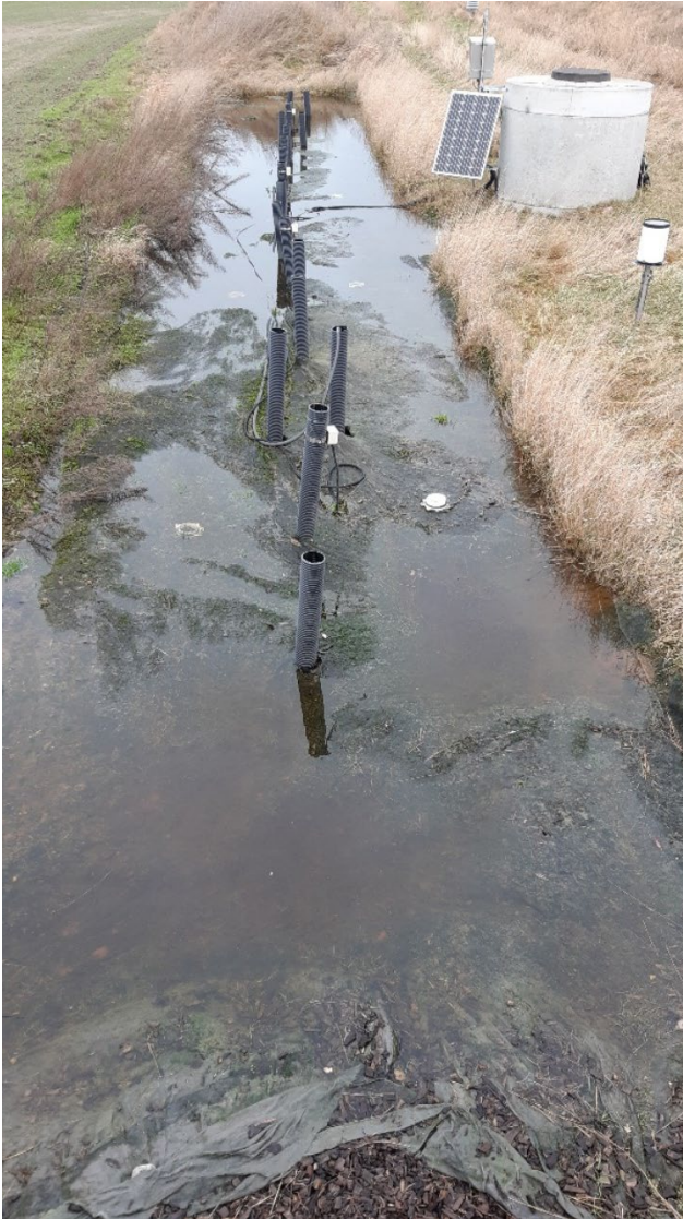
Foto 13: Der Drängraben steht unter Wasser. 4.1.2022 (Andreas Bauwe)
