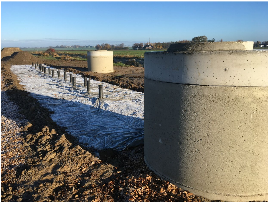
Foto 4: Blick auf den fertig gestellten Drängraben. 7.11.2017 (Juliana Tatzelt)
