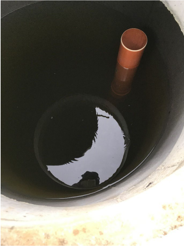
Foto 5: Blick in den Umleitungsschacht mit Notüberlauf. 12.3.2018 (Juliana Tatzelt)
