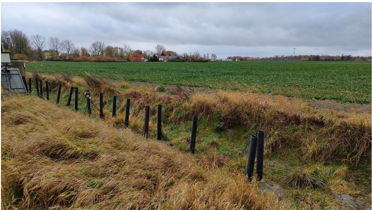
Foto 16: Der Drängraben wächst allmählich zu und die Holzackschnitzel wurden deutlich sichtbar abgebaut (ca. 50 cm Verlust). 16.11.2023 (Andreas Bauwe)
