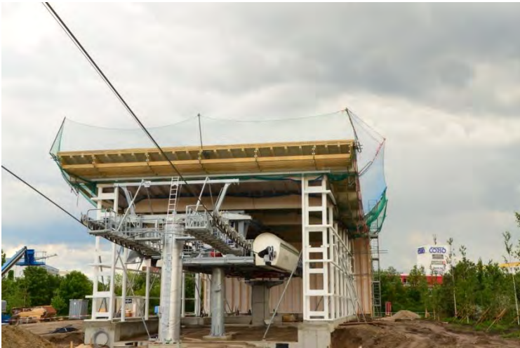
Abb. 1: Kopfstation der im Bau befindlichen Seilbahn, mit der die Besucher das gesamte Ausstellungsgelände überqueren können. Die Fahrtkosten sind in der Eintrittskarte enthalten. (alle Fotos Ganzlin)
