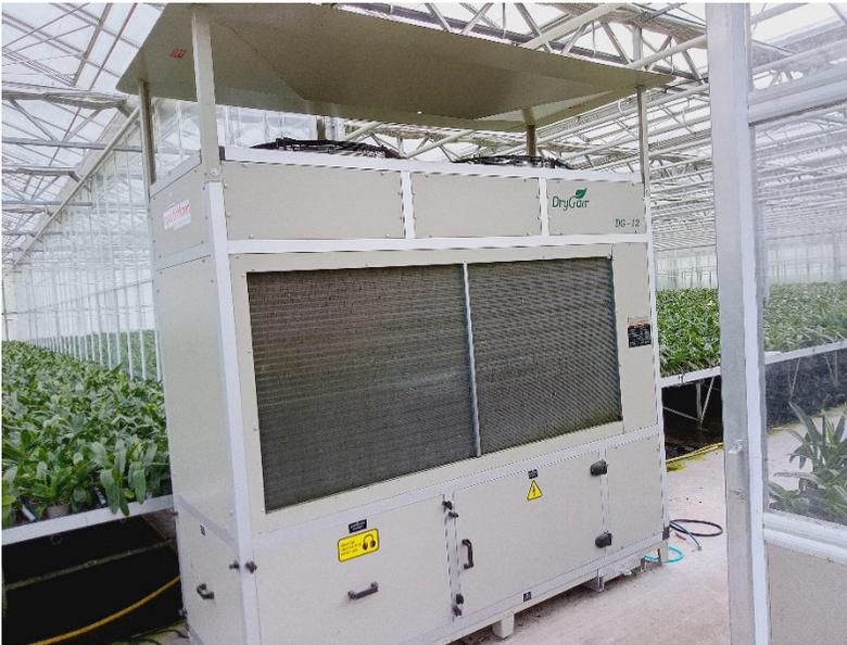
Abb. 5: Luftentfeuchtungsanlage im Betrieb Orchideen Dürbusch.
